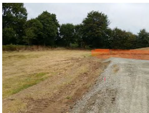
Figure 259 : Exemple de filet de chantier permettant de délimiter des emprises au sol.
